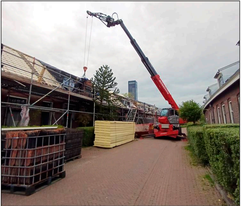
Een mooie foto van de renovatie, deze keer in de Halbertsmastraat. De nieuwe dakpannen worden op de steigers gehesen. De foto is gemaakt door Lia Rodenhuis.
